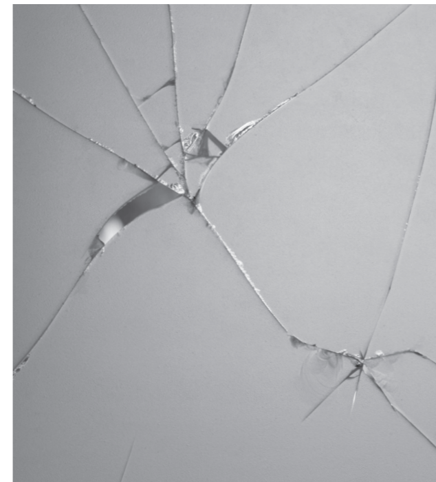
일반 유리 파손 형태
